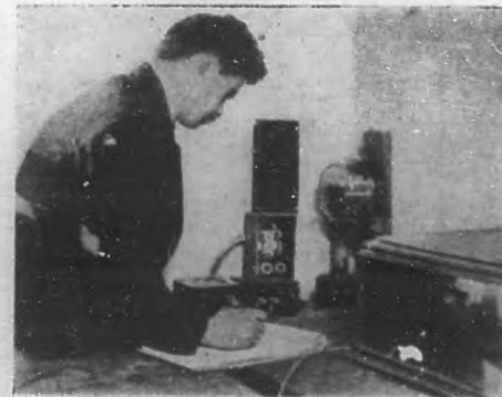
Midiendo el consumo de corriente de un receptor "todo eléctrico"
